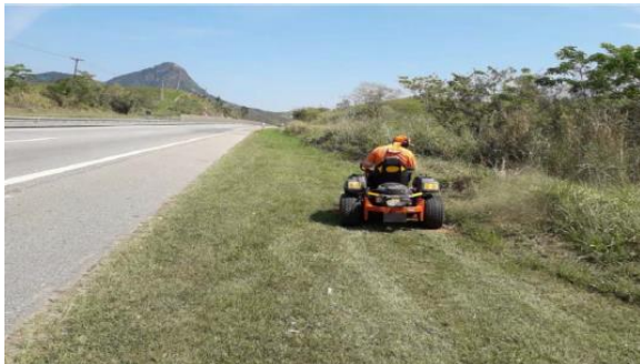
Figura 55 Roçada Mecânica – Km 15+500
