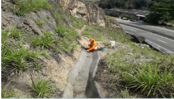
Figura 53 Reparo de caneleta
