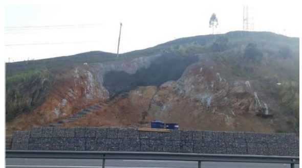
Figura 60 Recuperação de talude
