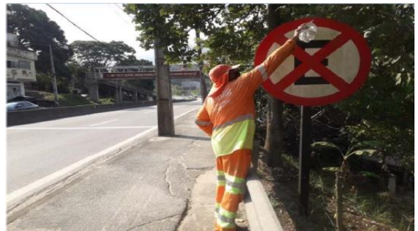
Figura 44 Limpeza de placa - Km 0+500
