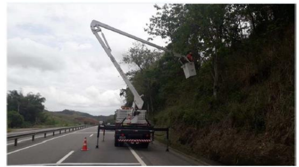
Figura 58 Poda de árvores - Km 7+500
