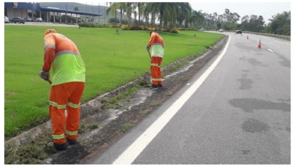
Figura 50 Limpeza de sarjeta 2
