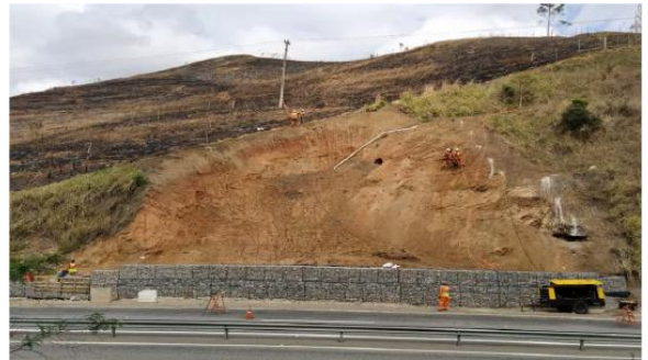
Figura 59 Obra de recuperação de talude
