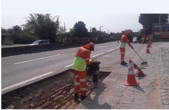
Figura 39 Reparo de acostamento
