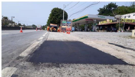
Figura 41 Reparo de acostamento concluído
