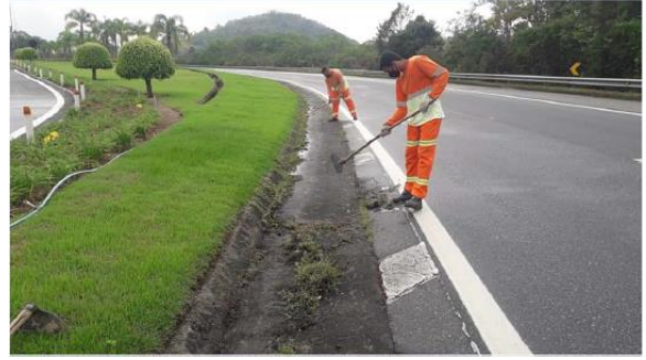
Figura 49 Limpeza de sarjeta - Km 23+000
