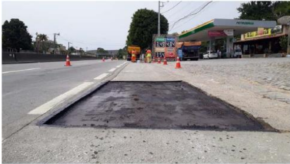
Figura 40 Reparo profundo - Km 13+500
