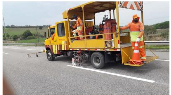
Figura 43 Pintura de faixa - Km 24+000
