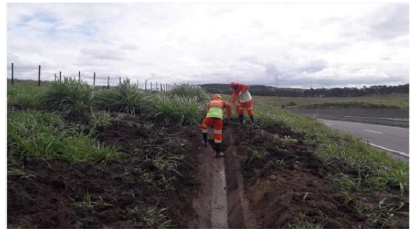
Figura 52 Limpeza de canaleta - Km 45+300
