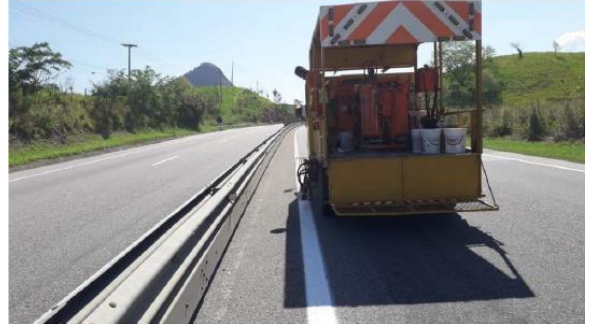
Figura 42 Pintura de faixa - Km 11+200
