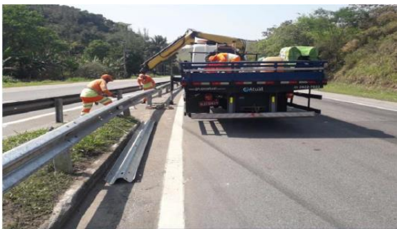
Figura 48 Reparo de dispositivo de segurança
