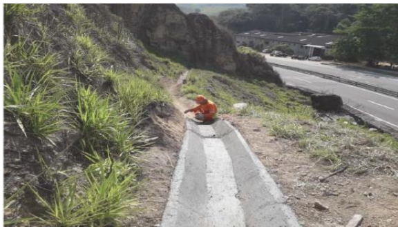
Figura 54 Reparo de caneleta - Km 02+500
